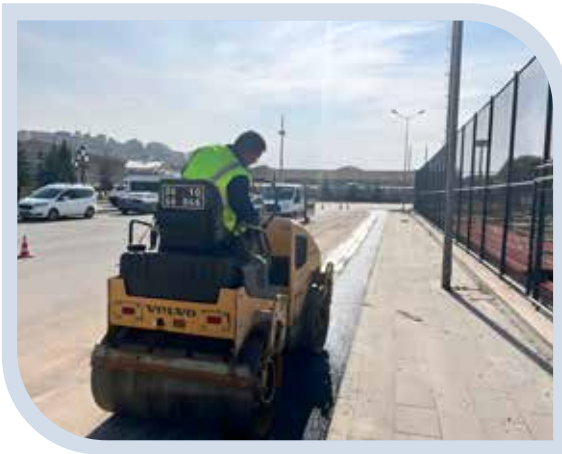
Cadde ve Sokak Asfalt Yama Çalışmaları
