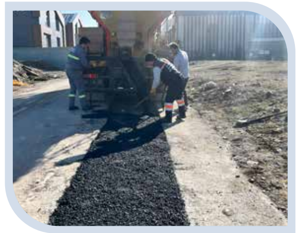
Cadde ve Sokak Asfalt Yama Çalışmaları
