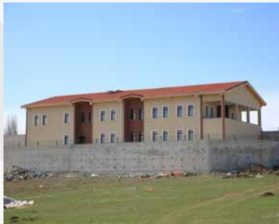
Halaçlı Mahalle Konağı
